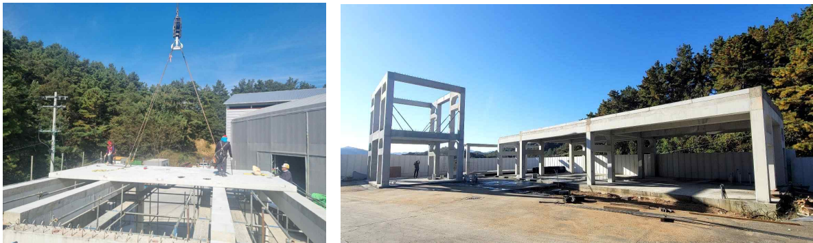
그림 4 중실형 솔리드 슬래브를 지붕과 적층 바닥재로 적용한 건축 PC시스템 (연면적:264m², 단층, 적층)
